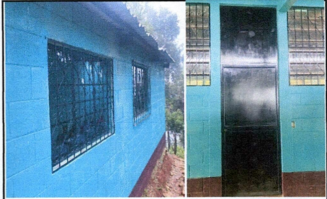
Foto 2: Mejoramiento de Ventanas y colocacion de balcones y en la siguiente fotografia mejoramiento de puerta y pintura
