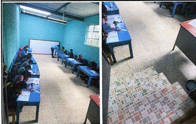
Foto 3: Mejoramiento de piso
