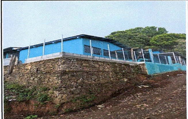
Foto 4: Mejoramiento de la escuela Finalizada
